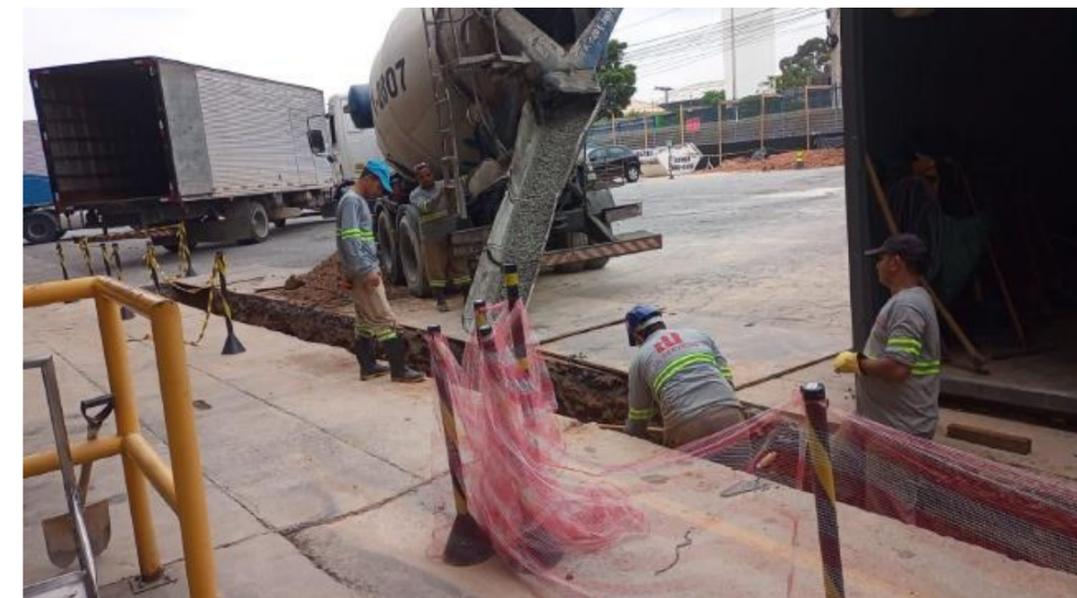
Galpão Barueri – Obra: sistema de drenagem - Escavação e concretagem de base das grelhas nas valas em frente as docas.
